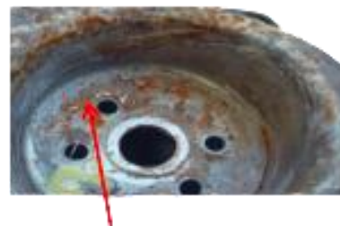
Corrosion causée par la migration du ressort
