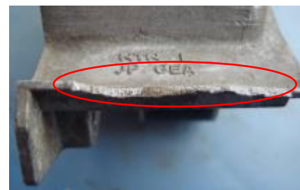
Пошкоджений кронштейн кріплення натягувача
